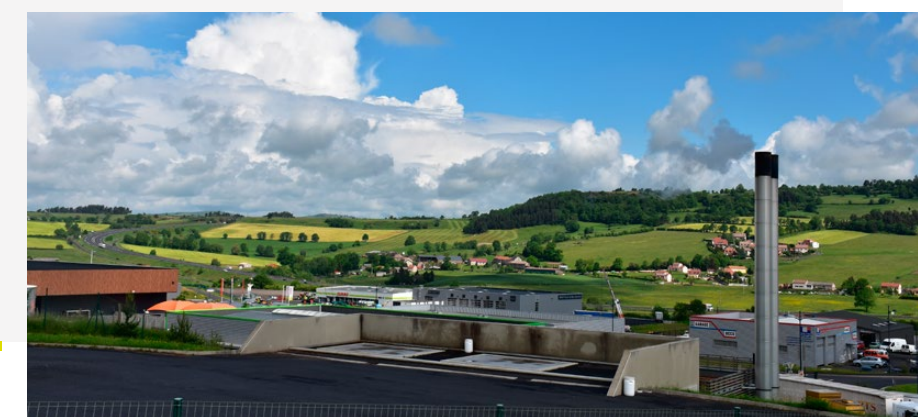
CHAUFFERIE BOIS CROZATIER - ZA du Crozatier
