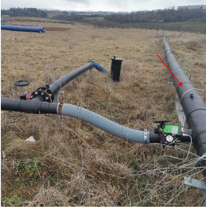
Figure 5 : Point de piquage sur un collecteur (cf. flèches en rouge)
