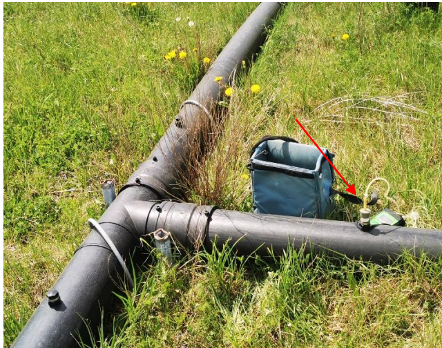
Figure 5 : Point de piquage sur un collecteur (cf. flèches en rouge)
